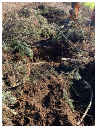
Photo du chantier en cours
